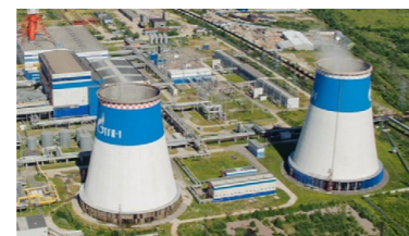
Реконструкция сетей канализации на Правобережной ТЭЦ-5 Санкт-Петербург, 2018
